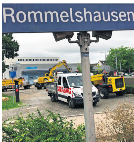
Die beauftragte Baufirma liefert schweres Werkzeug und Baumaterial an. Foto: Chris Lederer
