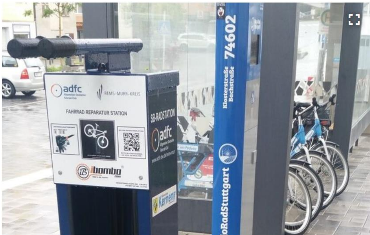
Eine der 36 Fahrradreparaturstationen im Rems-Murr-Kreis. Ein Teil ist bereits in Betrieb, zum Beispiel die Station in der Ortsmitte von Kernens-Stetten in der Klosterstraße. Foto: Winterling © Winterling
