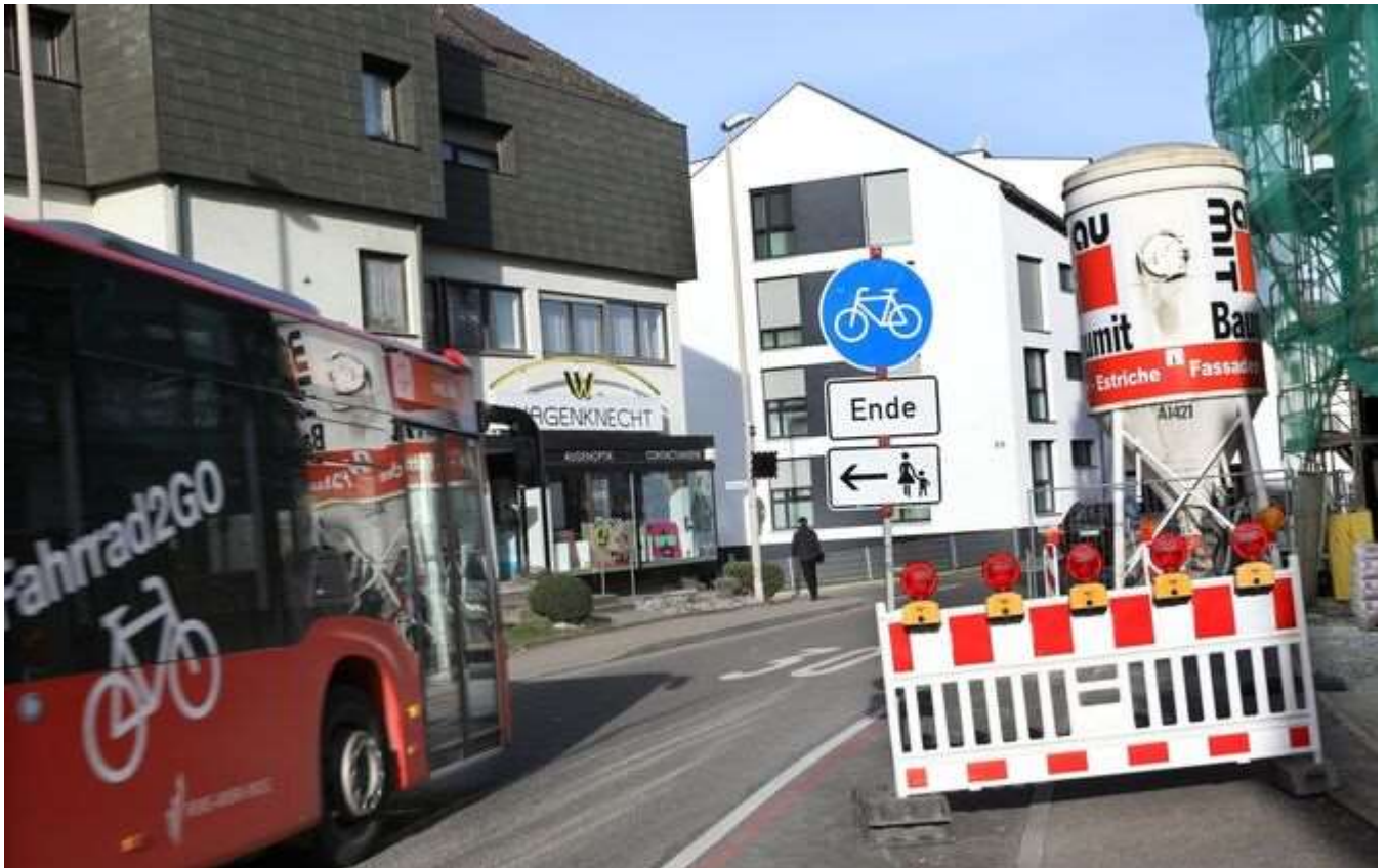
Fahrradfahrer am Ende: Baustelle an der Wallstraße. © Gaby Schneider
